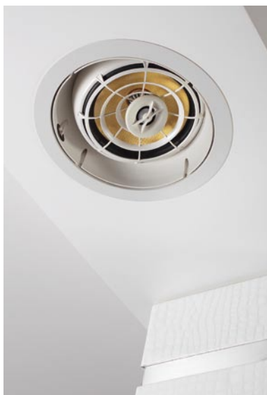
Динамики тыловых SpeakerCraft AIM8 встроены в потолочную балку и направлены в сторону слушателей
